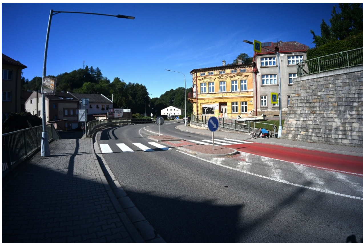
Obr. 6a, 6b – pokládka dlažby pro zrakově postižené, ul. Pod Jasany
