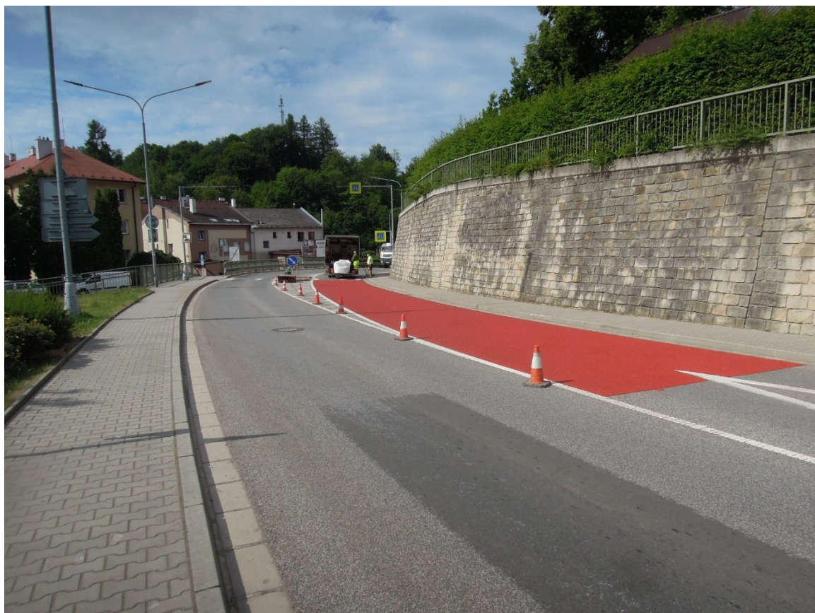
Obr. 2a, 2b - Dopravní opatření – ul. Pod Jasany – pokládka protismykové vrstvy typ Rocbinda
