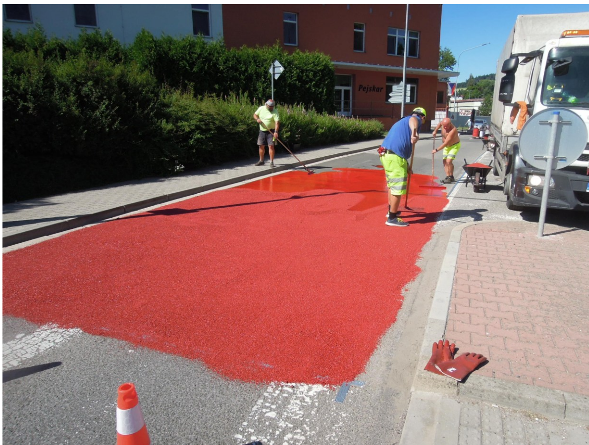
Obr. 3 – pokládka protismykové vrstvy typ Rocbinda – ulice Žďárská
