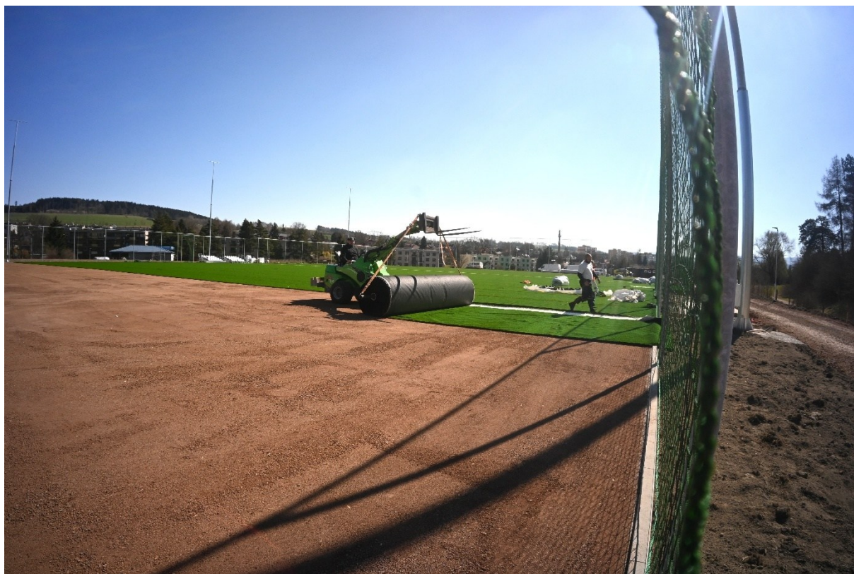
Obr. 9a, 9b – 9. 4. 2026 - Pokládání travních koberců na fotbalovém hřišti
