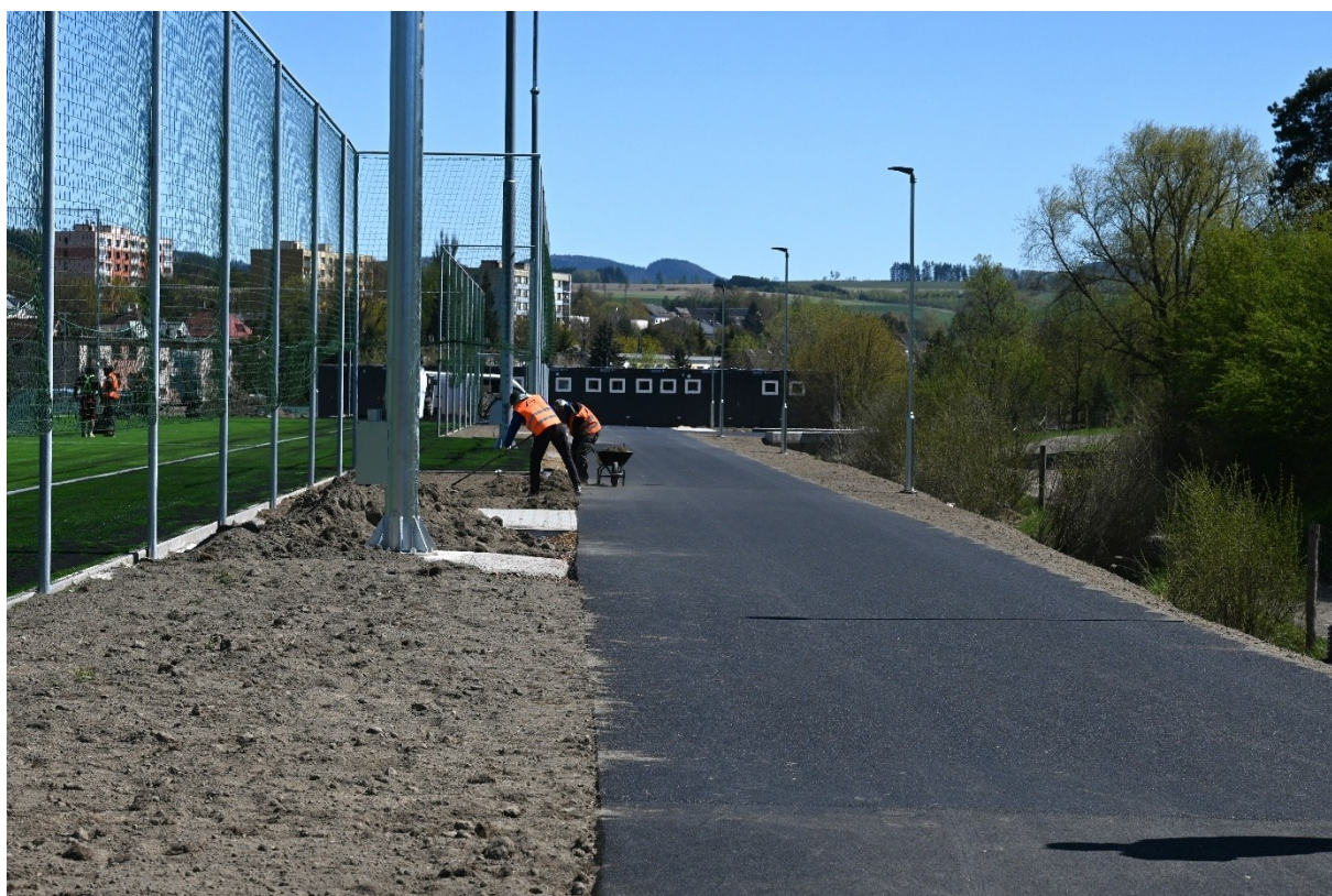
Obr. 17a, 17b – 29. 4. 2026 – Terénní úpravy
