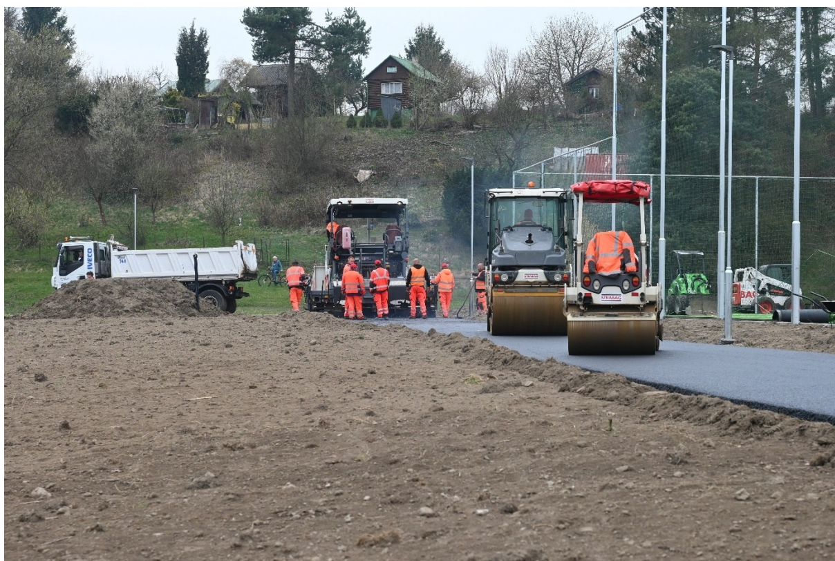
Obr. 12c, 12d - 17. 4. 2026 – Pokládka asfaltu na dráze pro in-line bruslení
