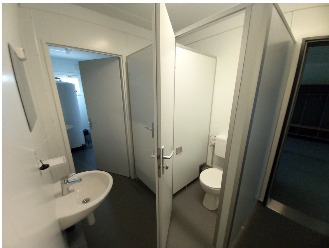
Obr. 20b - buňkoviště interiér - WC sportovci – stav ze dne 22. 5. 2026
