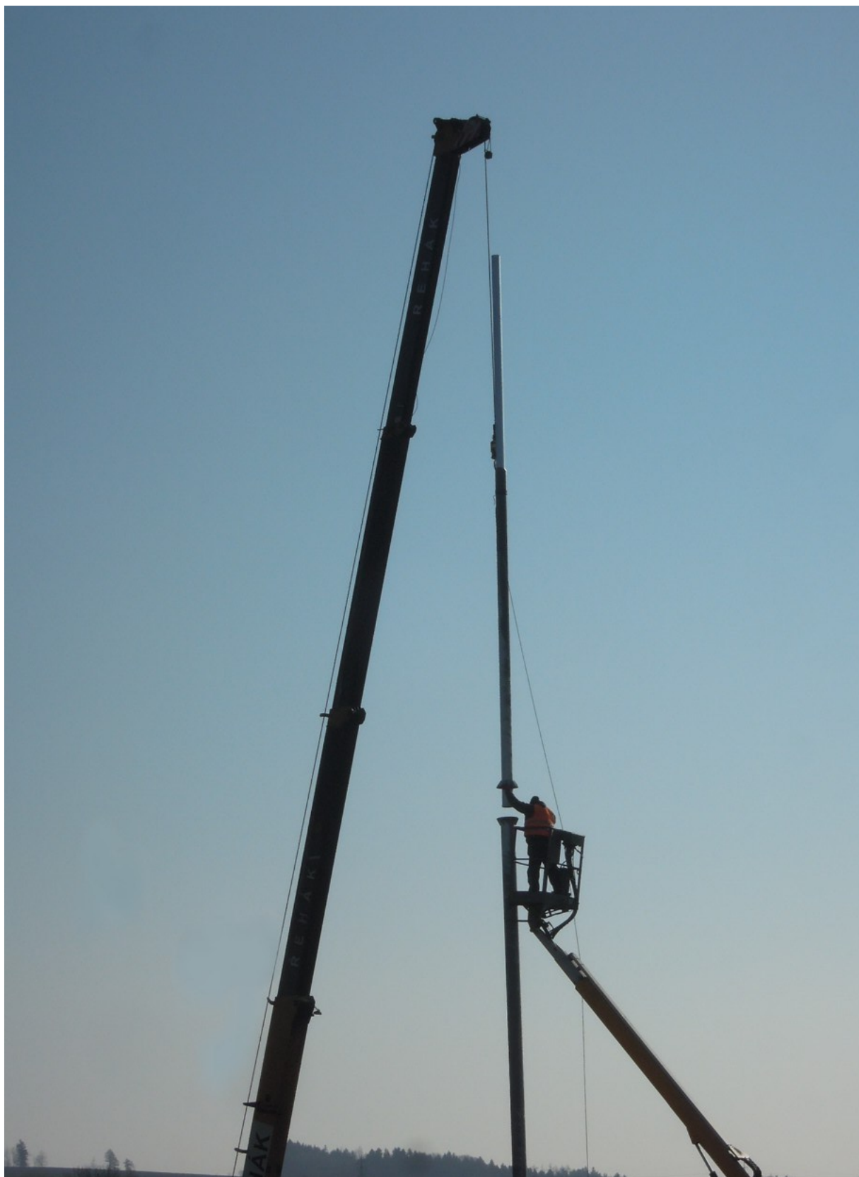
Obr. 8c – 18. 3. 2026 – Stavba stožárů pro osvětlení fotbalového hřiště
