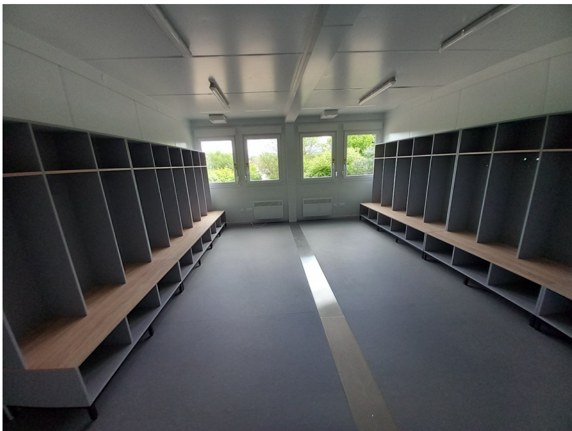
Obr. 19a, 19b – buňkoviště interiér – šatny pro sportovce – stav ze dne 22. 5. 2026
