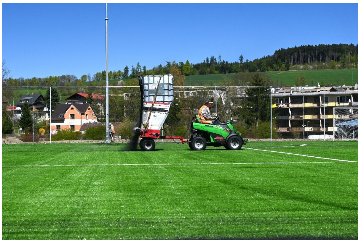
Obr. 16a, 16b – 29. 4. 2026 – Zapravování granulátu do umělého travního koberce fotbalového hřiště
