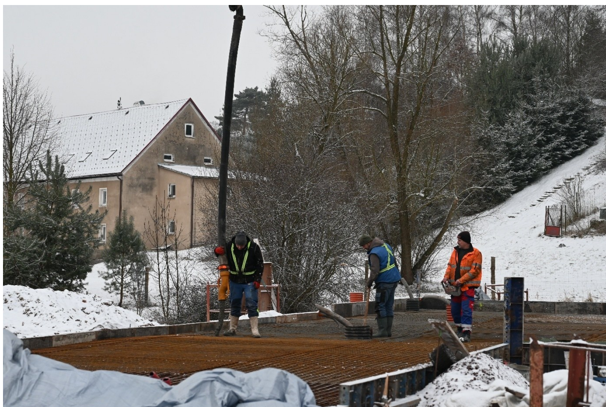
Obr. 7a, 7b – 17. 2. 2026 – Realizace betonové základové desky pro zázemí hřiště
