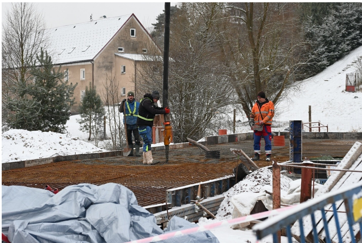
Obr. 7c, 7d – 17. 2. 2026 – Realizace betonové základové desky pro zázemí hřiště
