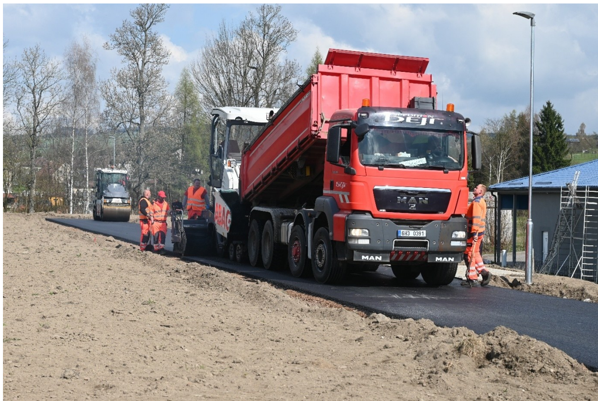
Obr. 12a, 12b - 17. 4. 2026 – Pokládka asfaltu na dráze pro in-line bruslení
