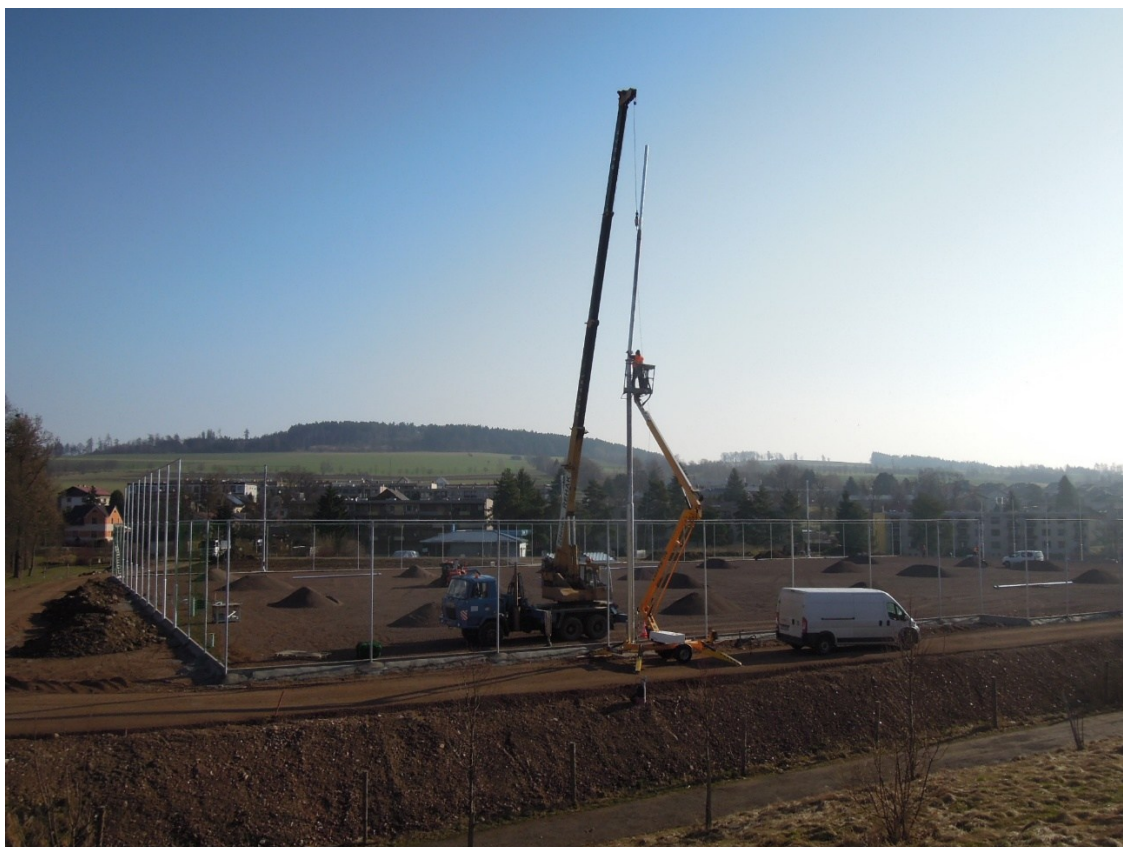
Obr. 8b – 18. 3. 2026 – Stavba stožárů pro osvětlení fotbalového hřiště
