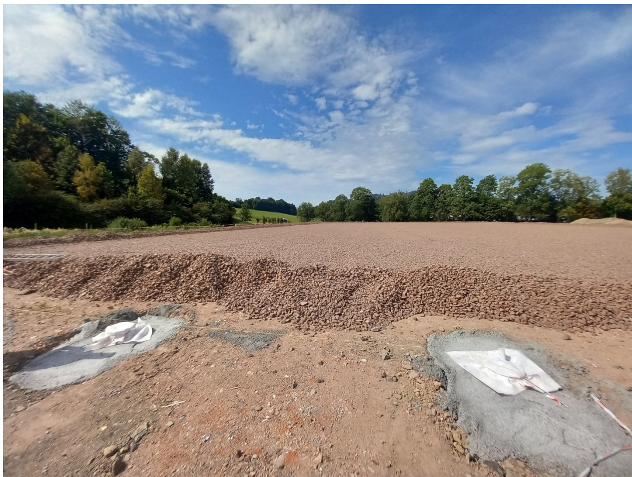
Obr. 5 – 27. 8. 2025 - Pokládka štěrku pro fotbalové hřiště
