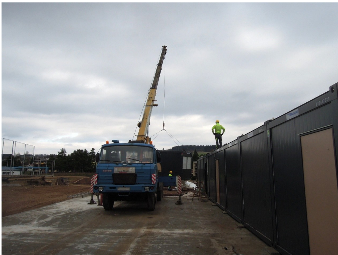
Obr. 8a – 16. 3. 2026 – Instalace kontejnerových buněk pro zázemí sportoviště
