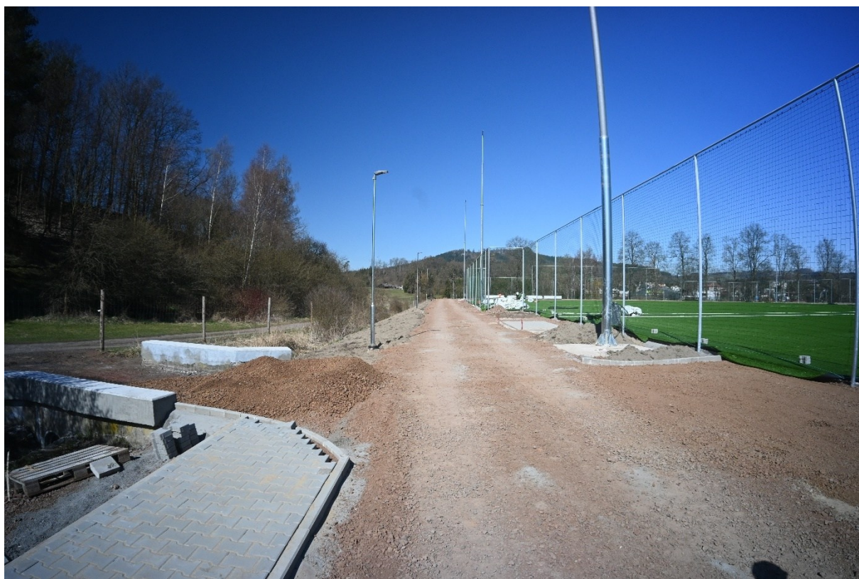
Obr. 10 – 9. 4. 2026 – Část dráhy pro in-line bruslení před pokládkou asfaltu
