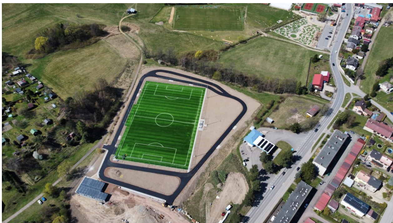
Obr. 13a, 13b - 18. 4. 2026 – Stavba z ptačí perspektivy
