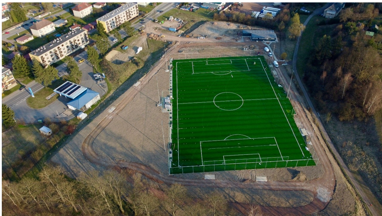
Obr. 11a, 11b – 11. 4. 2026 - Stavba z ptačí perspektivy
