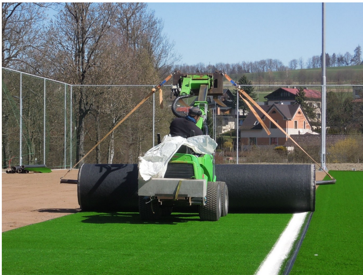
Obr. 9c, 9d – 9. 4. 2026 – Pokládání travních koberců na fotbalovém hřišti
