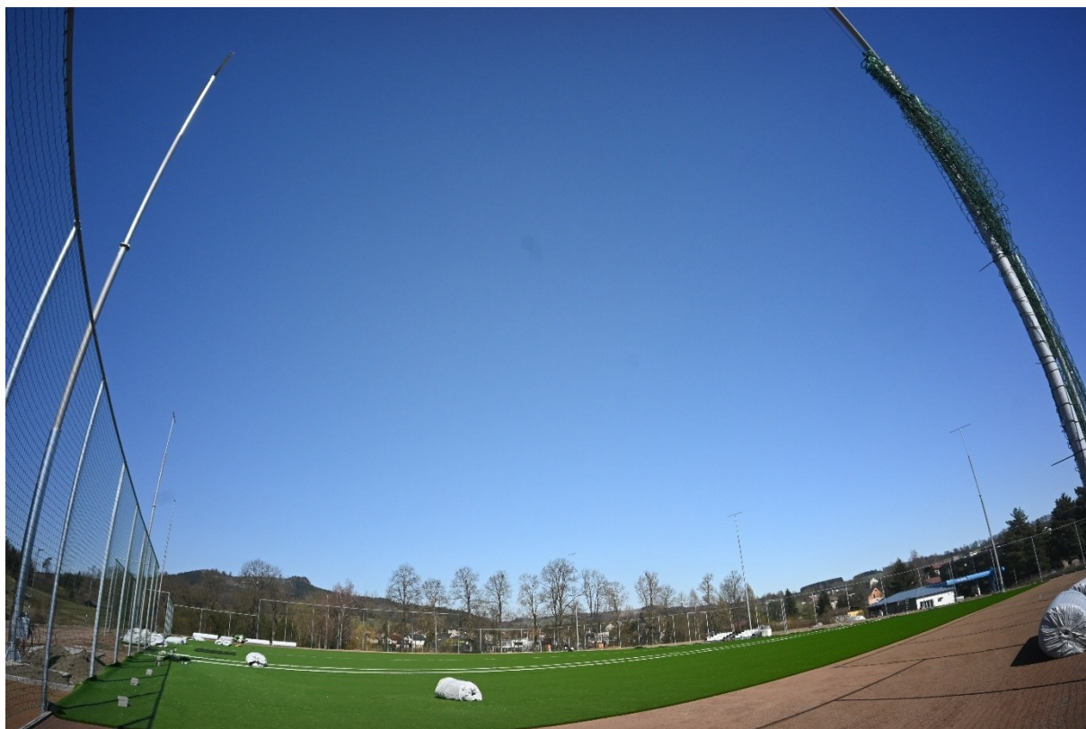
Obr. 9e – 9. 4. 2026 – Pokládka travních koberců na fotbalovém hřišti
