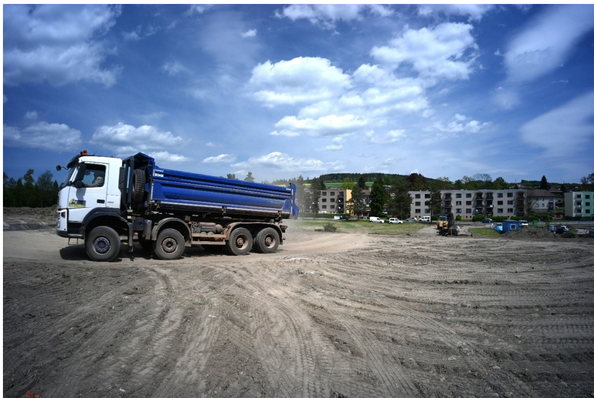
Obr. 3a, 3b – 14. 5. 2025 - Průběh stavby
