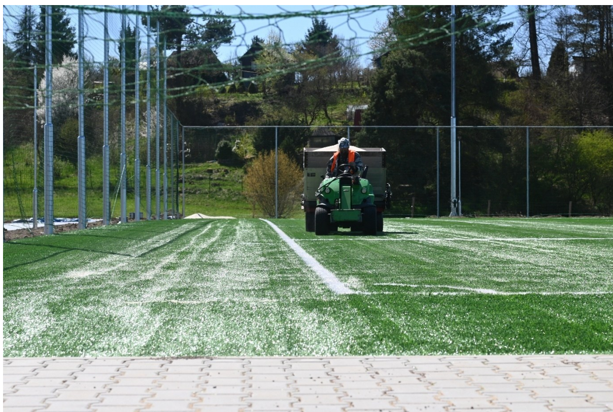
Obr. 15a, 15b – 22. 4. 2026 - Zapravování písku do umělého travního koberce fotbalového hřiště
