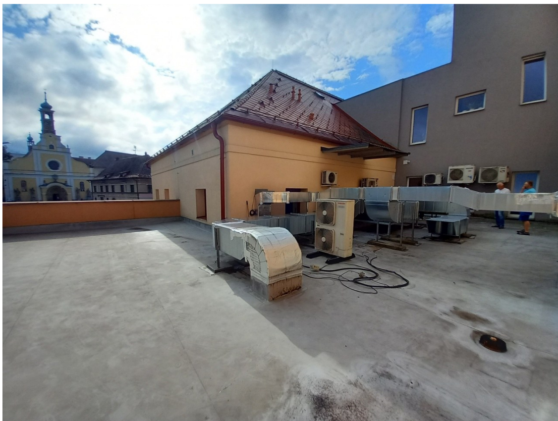
Obr. 3a, 3b – Průběh instalace vzduchotechniky na střeše ze dne 23.07.2025
