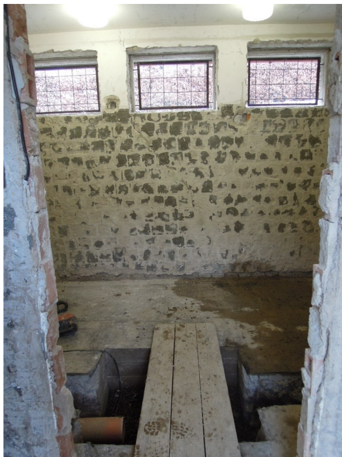
Obr. 4a, 4b – z průběhu stavby
