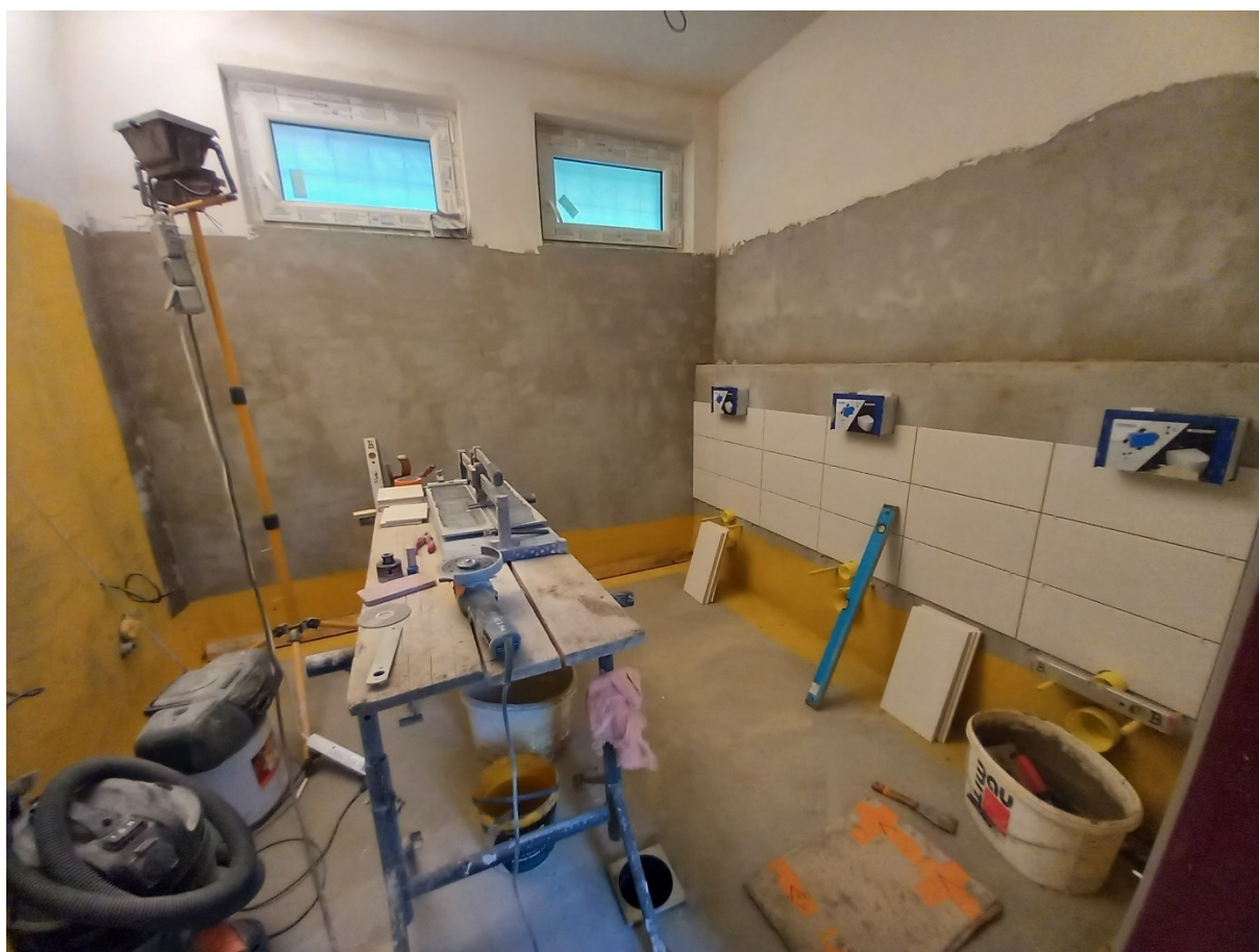
Obr. 5a, 5b – z průběhu stavby
