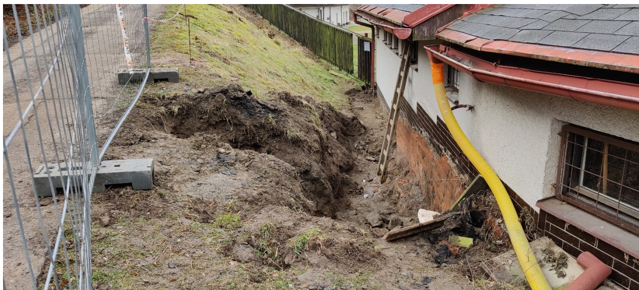
Obr. 3a, 3b – průběh stavby
