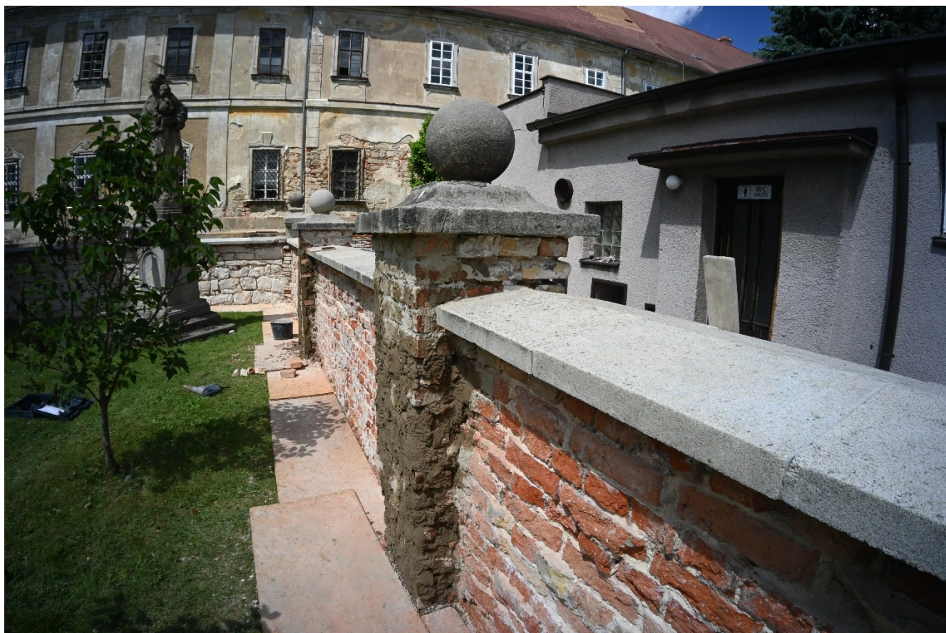
Obr. 4c – průběh udržovacích prací ze dne 26.06.2025 – zeď část D1
