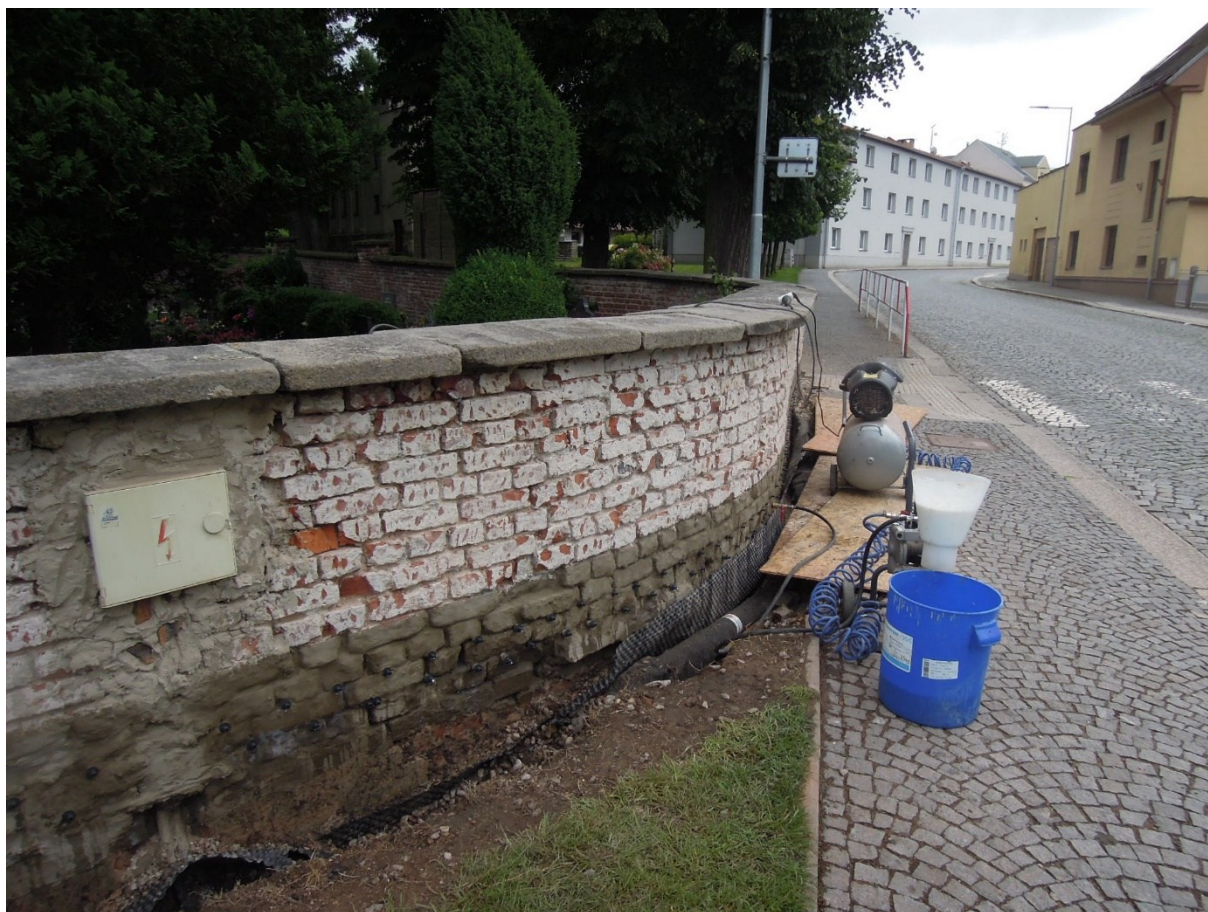
Obr. 6 – průběh udržovacích prací – odvlhčování zdi část C – ze dne 31.07.2025
