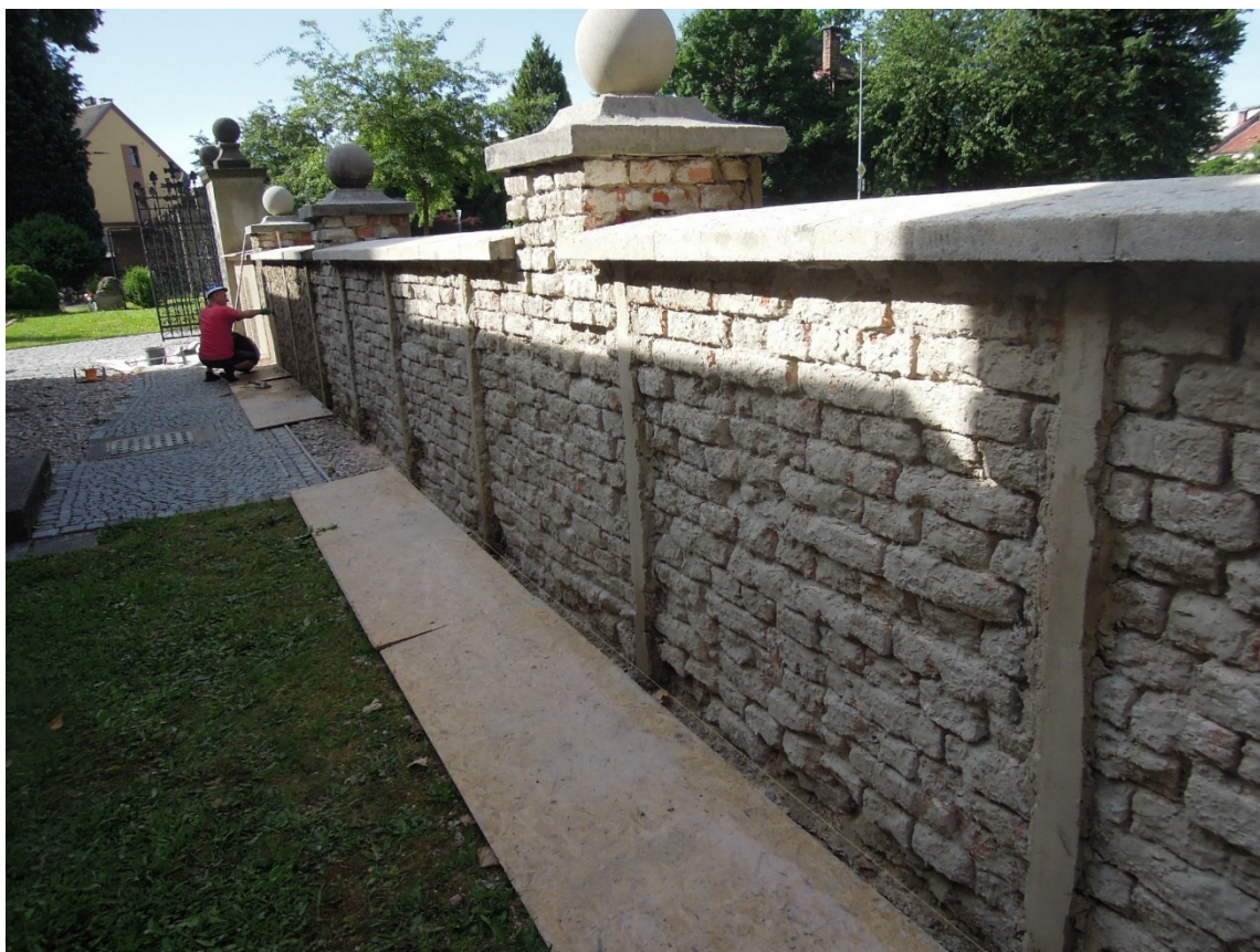
Obr. 4a, 4b – průběh udržovacích prací ze dne 26.06.2025 – zedř část D1
