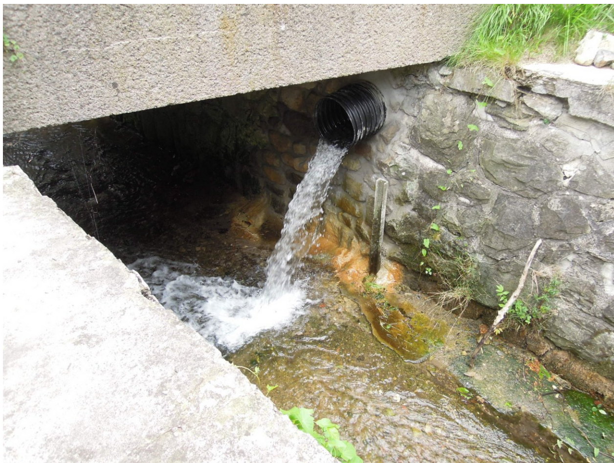
Obr. 2 – nový výústní objekt vodního náhonu, červenec 2025
