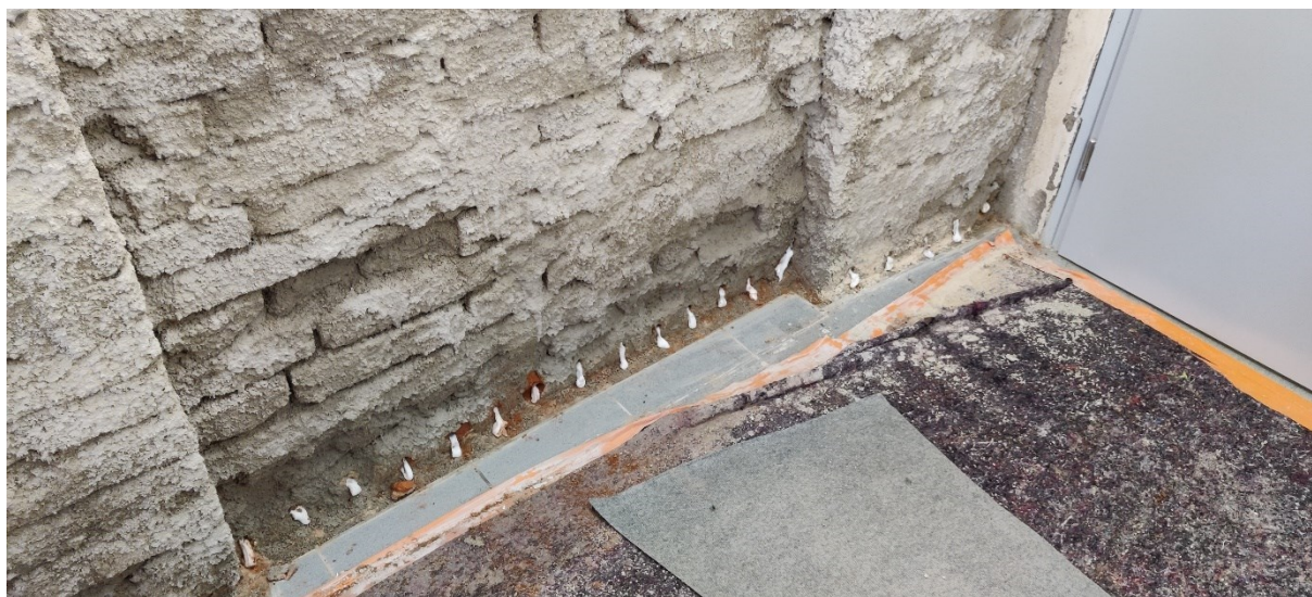
Obr. 3a, 3b, 3c – z realizace – injektáž zdiva
