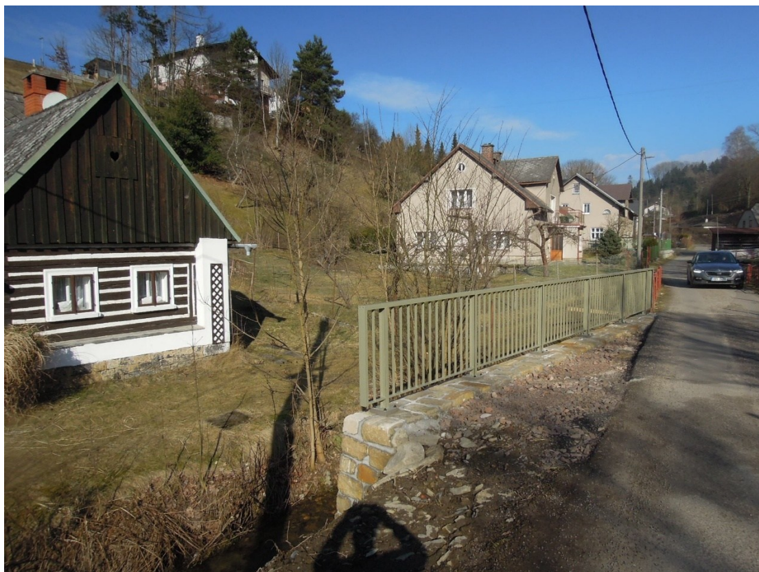
Obr. 6a – stav po dokončení stavby začátkem března 2026
