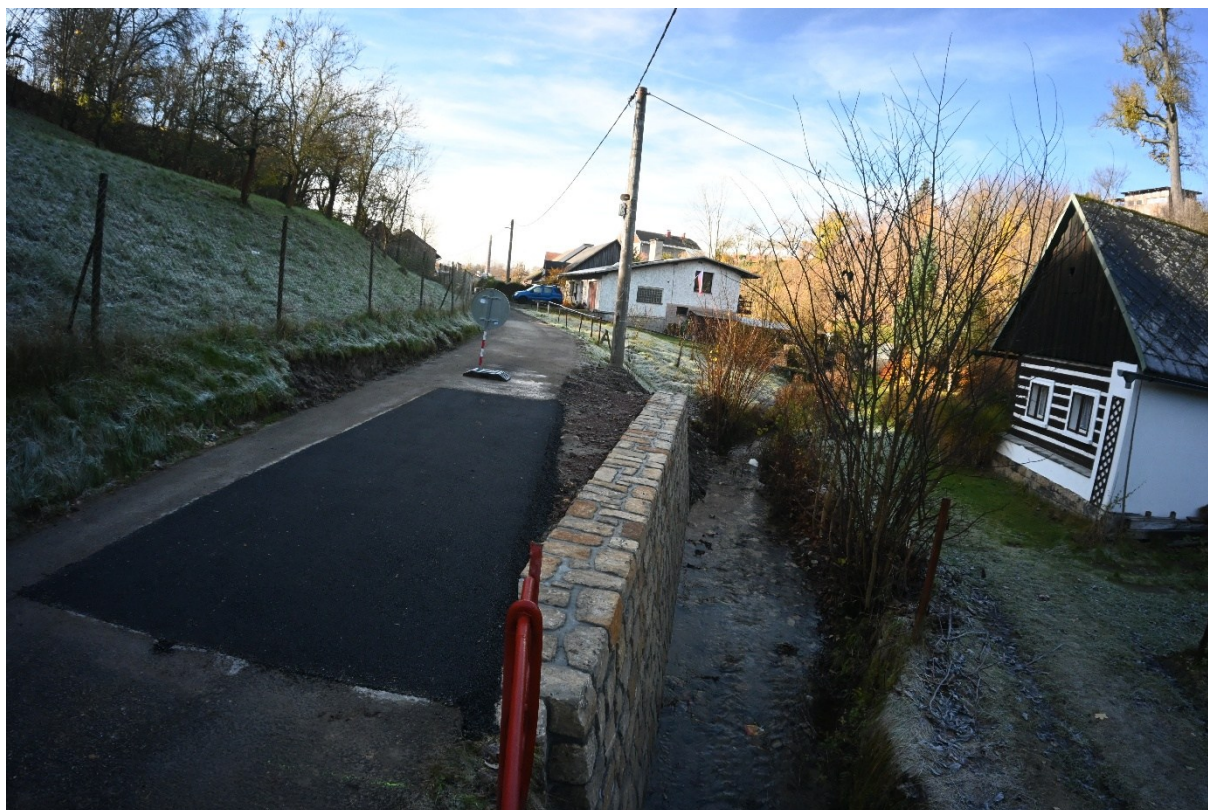
Obr. 5a, 5b – stav po dokončení opěrné zdi – 31. 10. 2025
