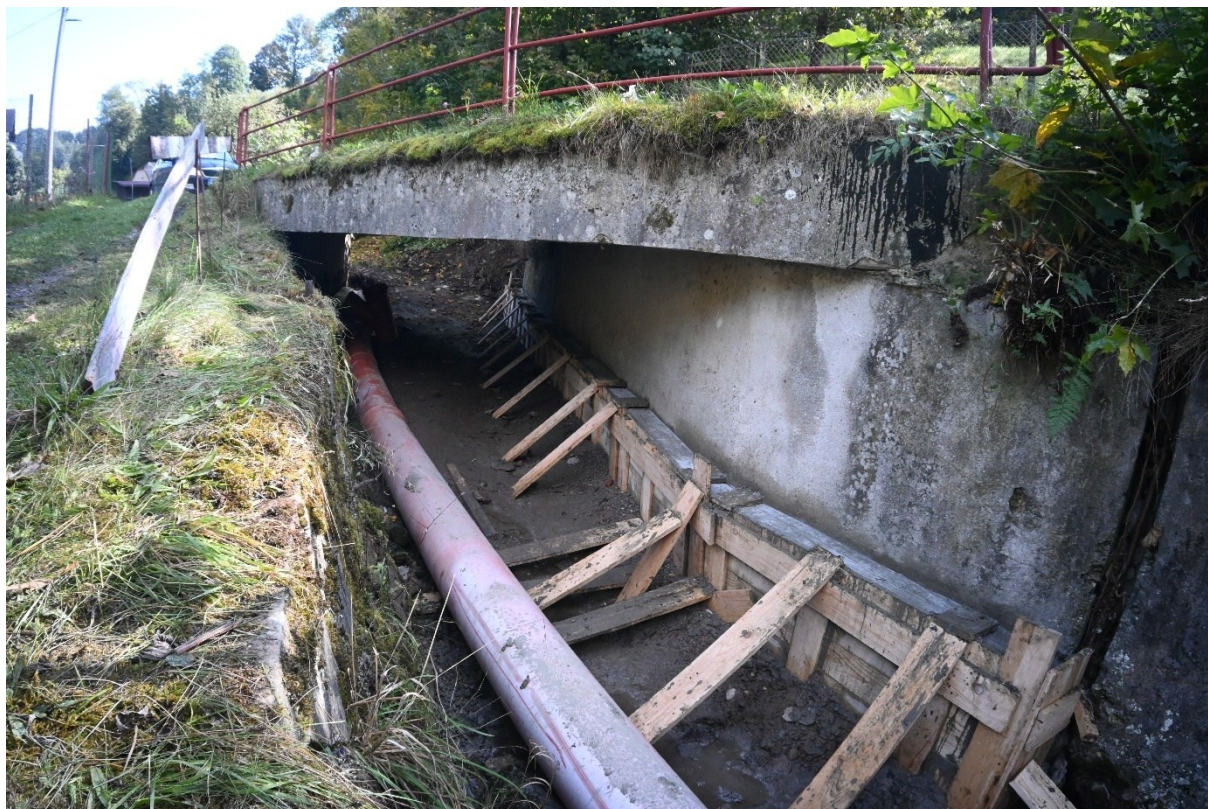
Obr. 4 – stabilizace základové spáry v úpatí mostní konstrukce – levý břeh vodního toku Ledhujka a převedení vody z vodního toku přes staveniště potrubím KG – stav ze dne 03.10.2025
