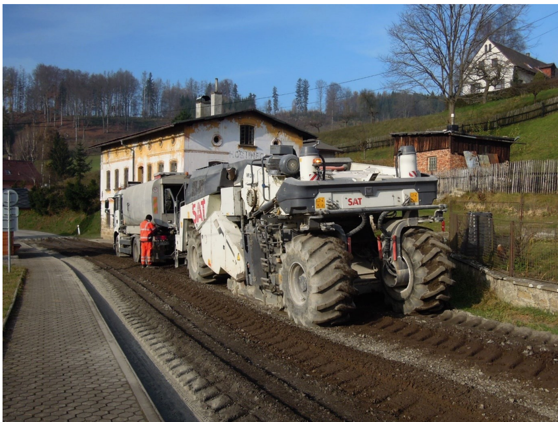
Obr. 4 – recyklace podkladních vrstev – doplnění zemních vrstev cementem
