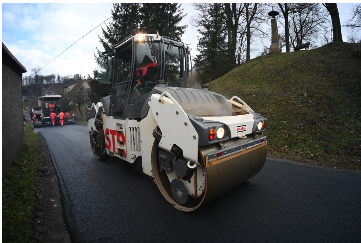
Obr. 7 – asfaltování – pokládka a válcování spodní vrstvy asfaltobetonu
