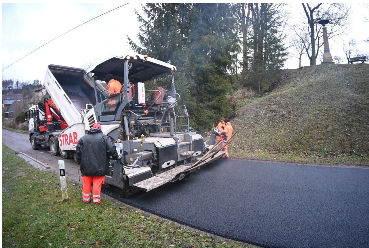
Obr. 6 – asfaltování – pokládka spodní vrstvy asfaltobetonu
