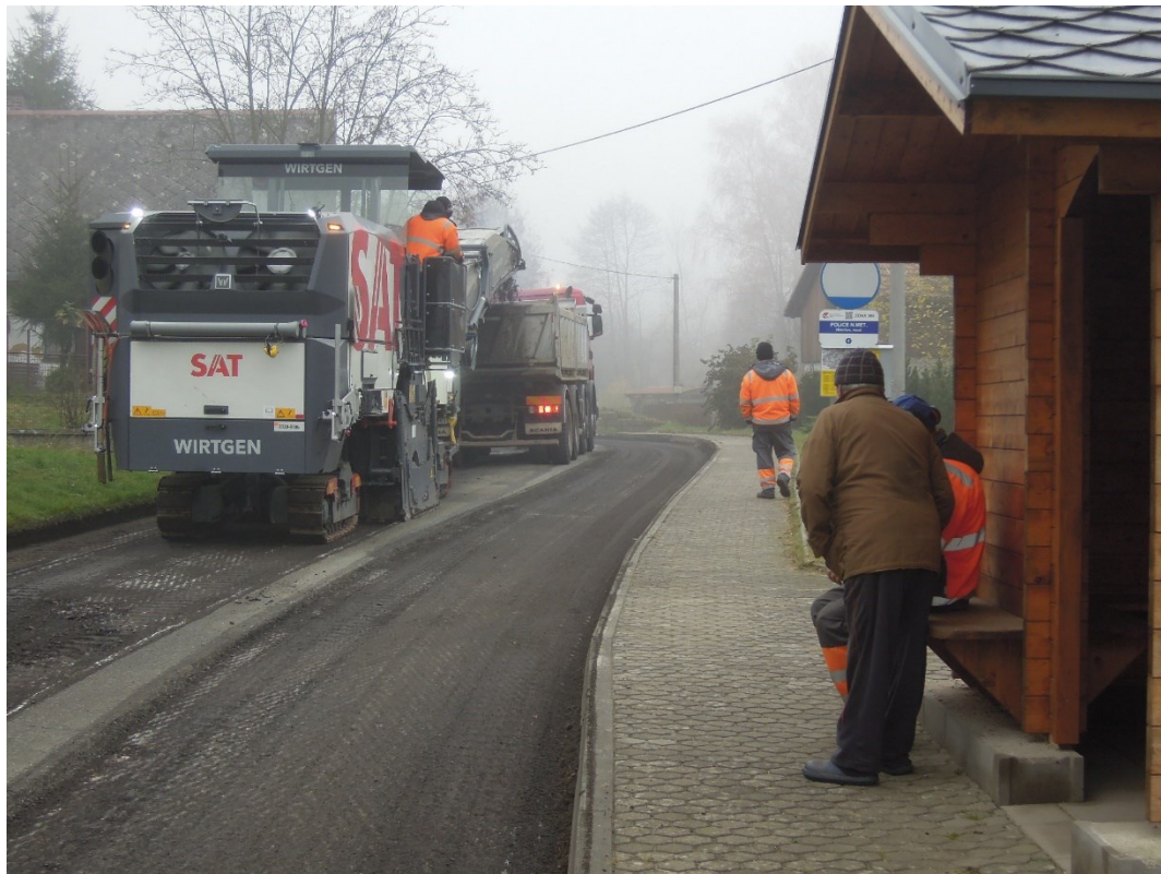
Obr. 2 Frézování stávajícího asfaltového povrchu
