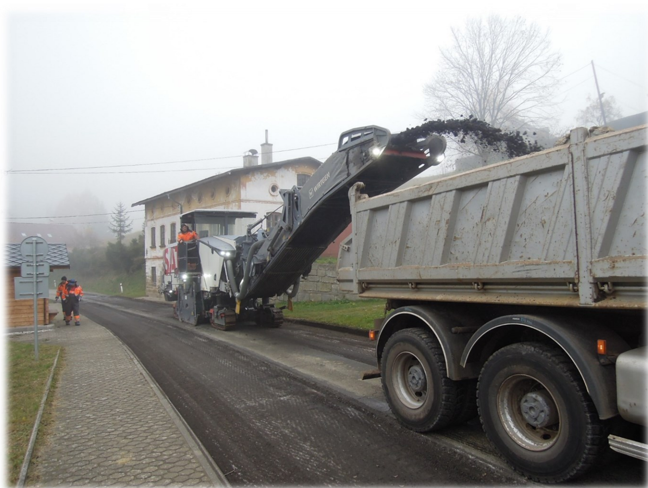
Obr. 1 Frézování stávajícího asfaltového povrchu
