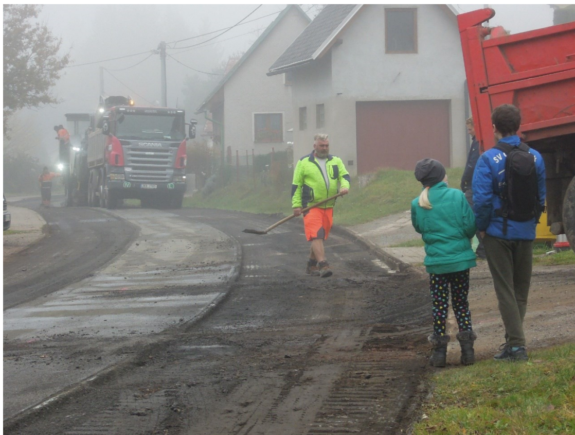
Obr. 3 Frézování stávajícího asfaltového povrchu
