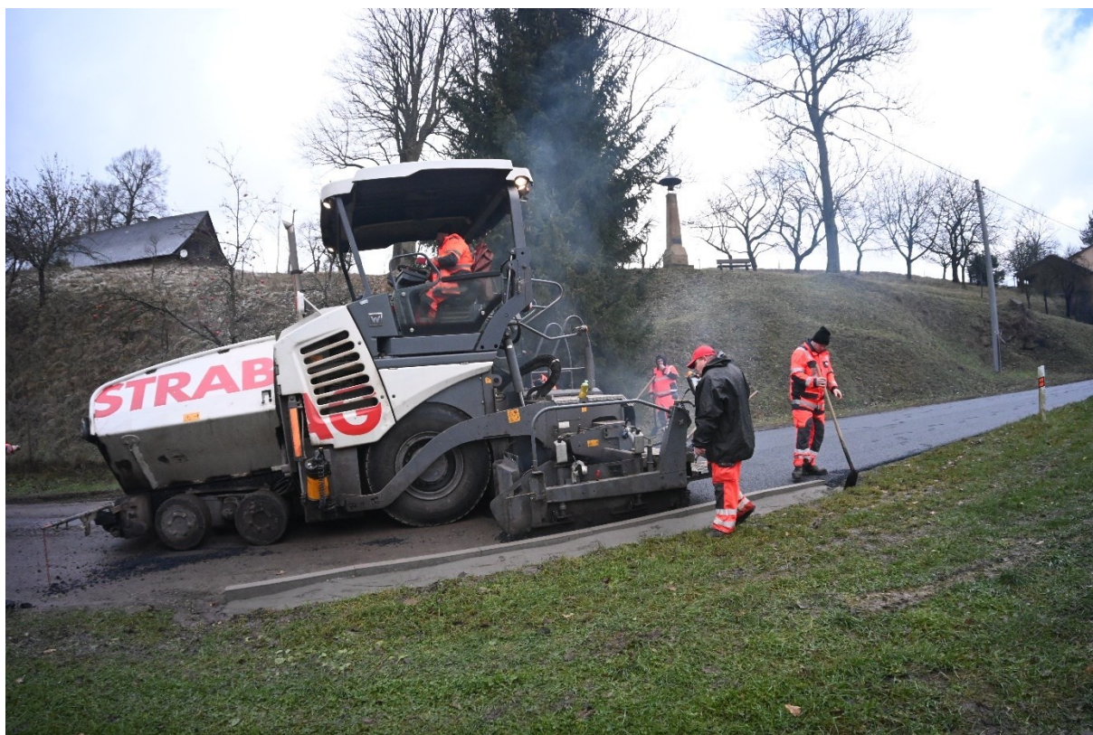
Obr. 9 – asfaltování – pokládka spodní vrstvy asfaltobetonu
