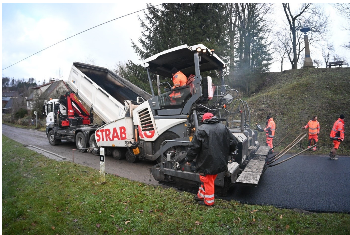
Obr. 8 – asfaltování – pokládka spodní vrstvy asfaltobetonu
