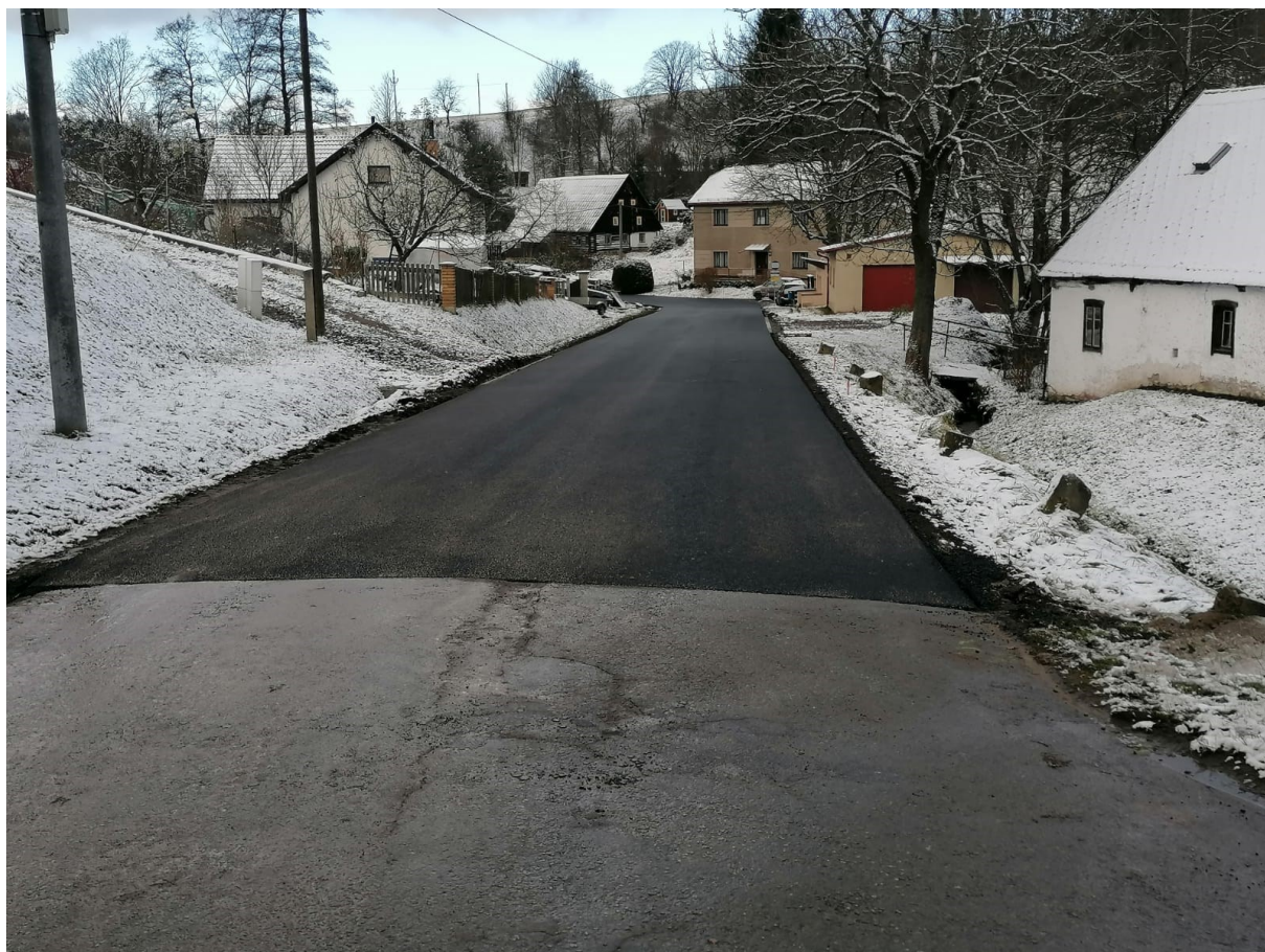
Obr. 12 – přechod úseků s novým a původním asfaltovým povrchem vozovky
