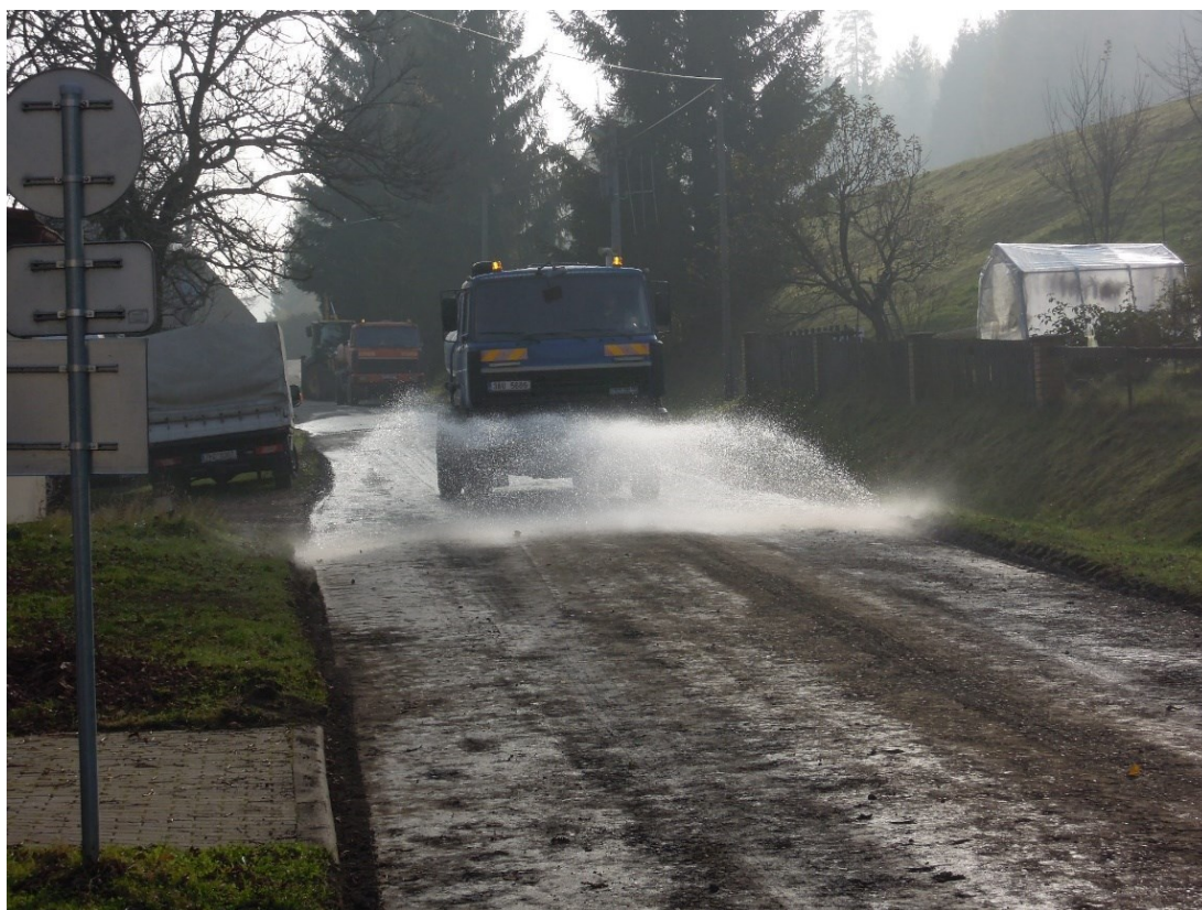
Obr. 5 – skrápění podkladních vrstev po recyklaci
