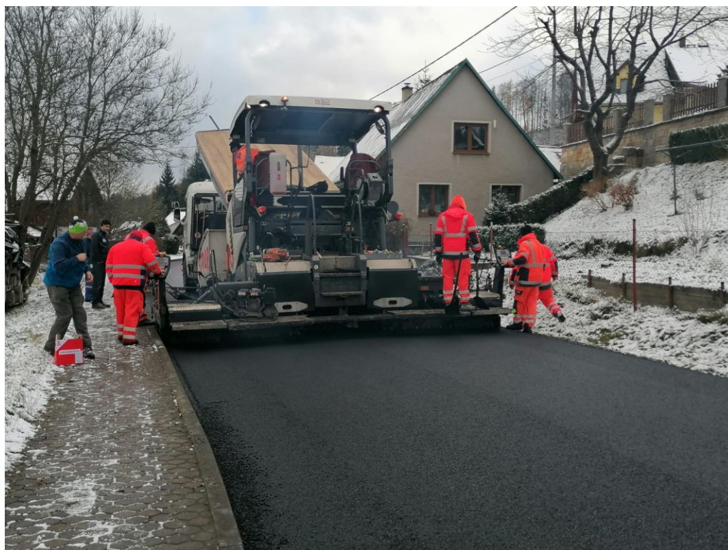
Obr. 11 – asfaltování – pokládka vrchní vrstvy asfaltobetonu
