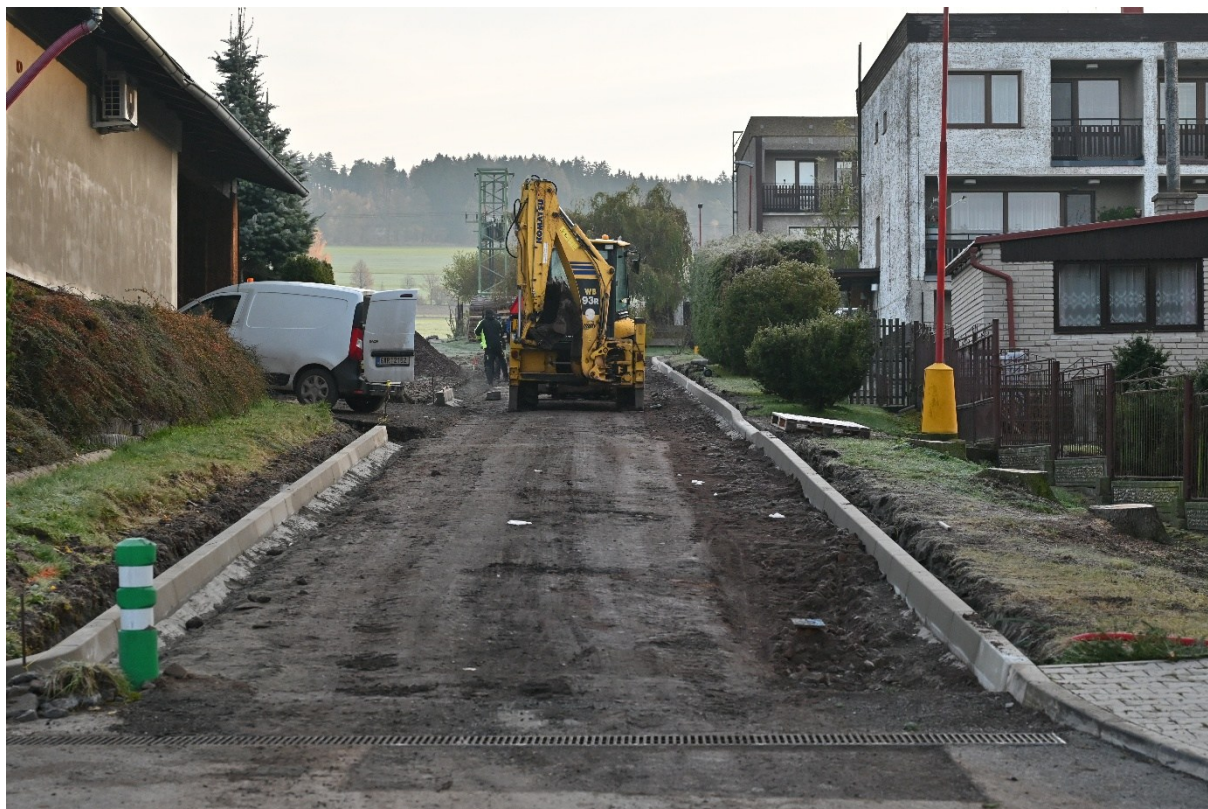
Obr. 3 – Rekonstrukce části ulice Smetanova na pozemku p.p.č. 769/68 v k.ú. Velká Ledhuje - přípravné práce – stav ke dni 05.11.2025
