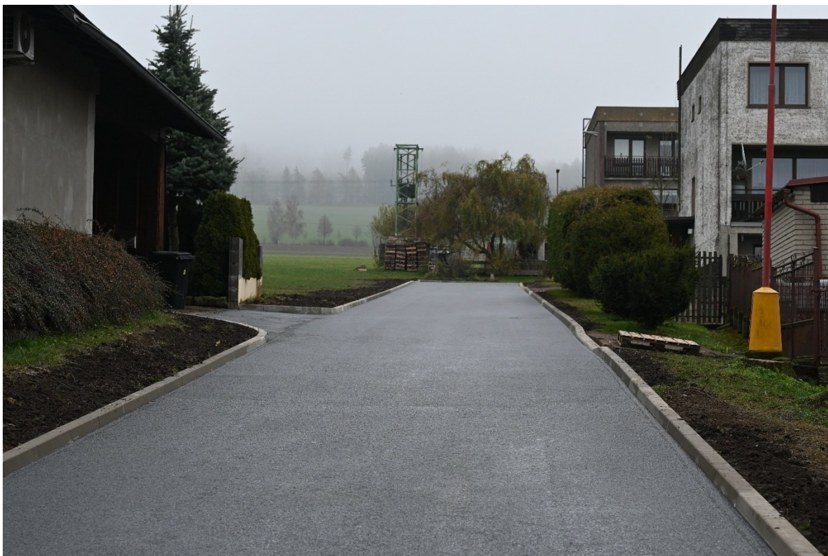
Obr. 8 – Dokončené práce - stav ke dni 12.11.2025 odpoledne
