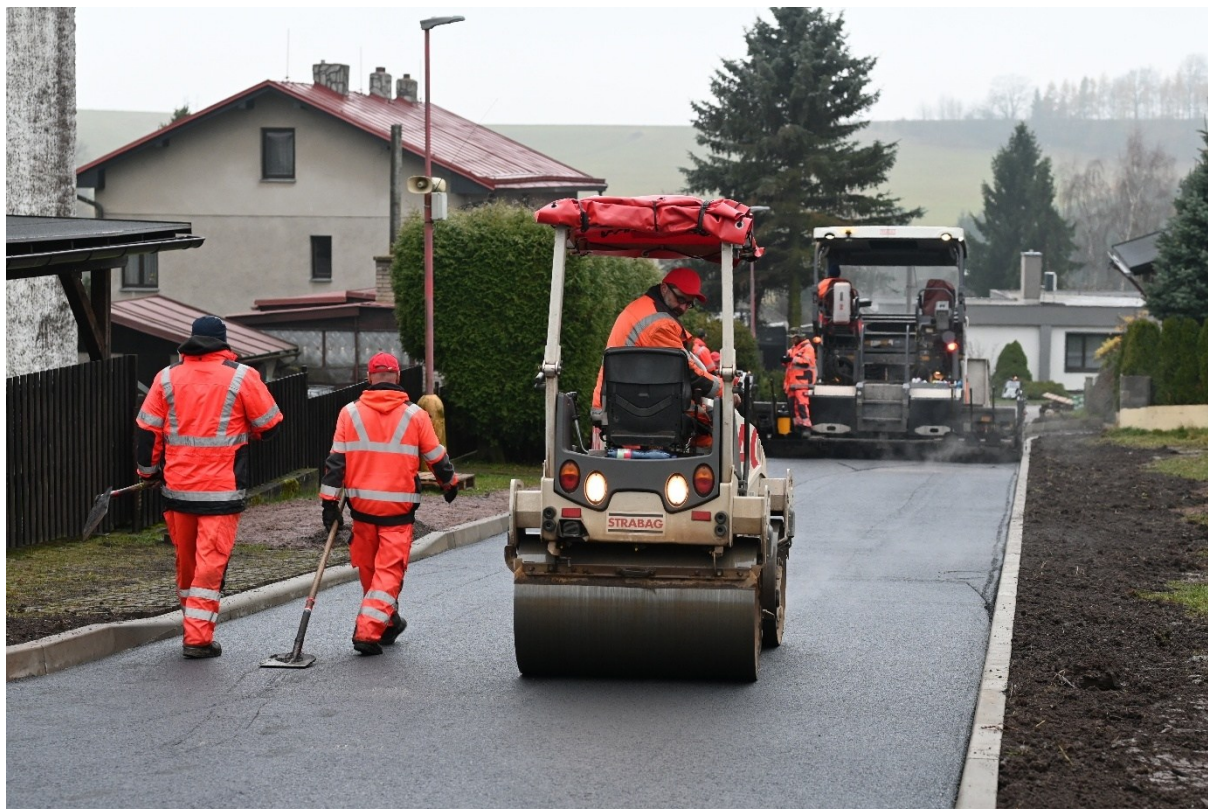
Obr. 6a, 6b – Asfaltérské práce - pokládka podkladní vrstvy asfaltobetonu - stav ze dne 11.11.2025 odpoledne
