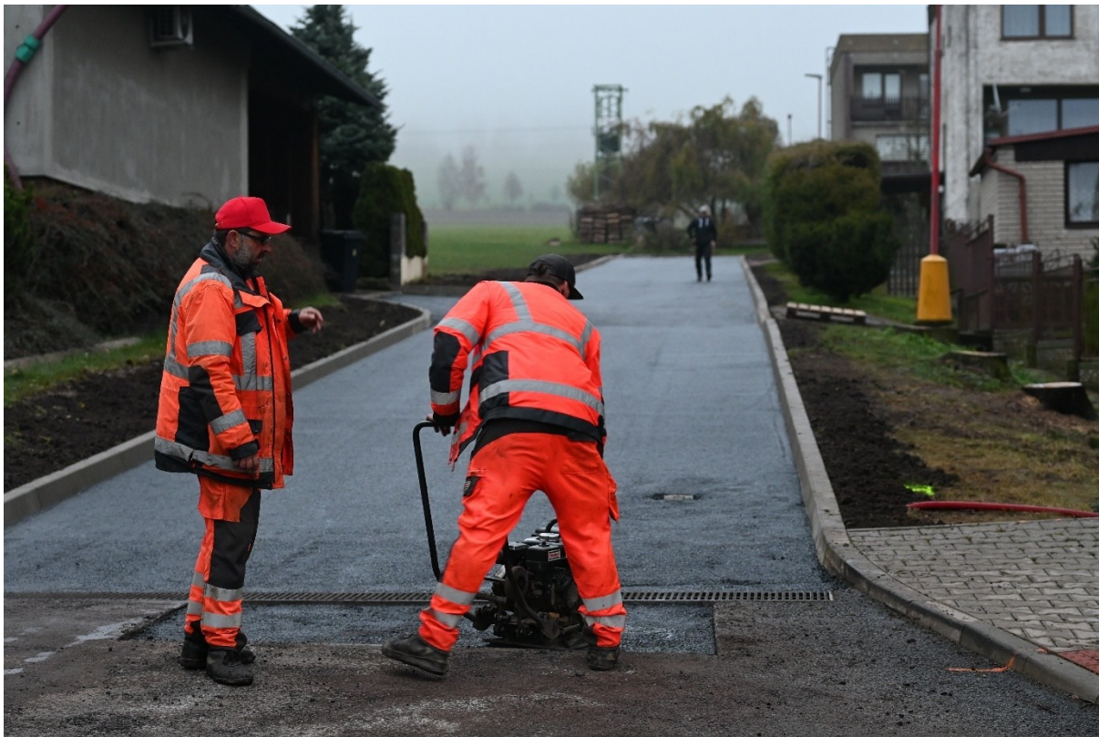
Obr. 7 – Asfaltérské práce - pokládka obrusné vrstvy asfaltobetonu - stav ke dni 12.11.2025 dopoledne
