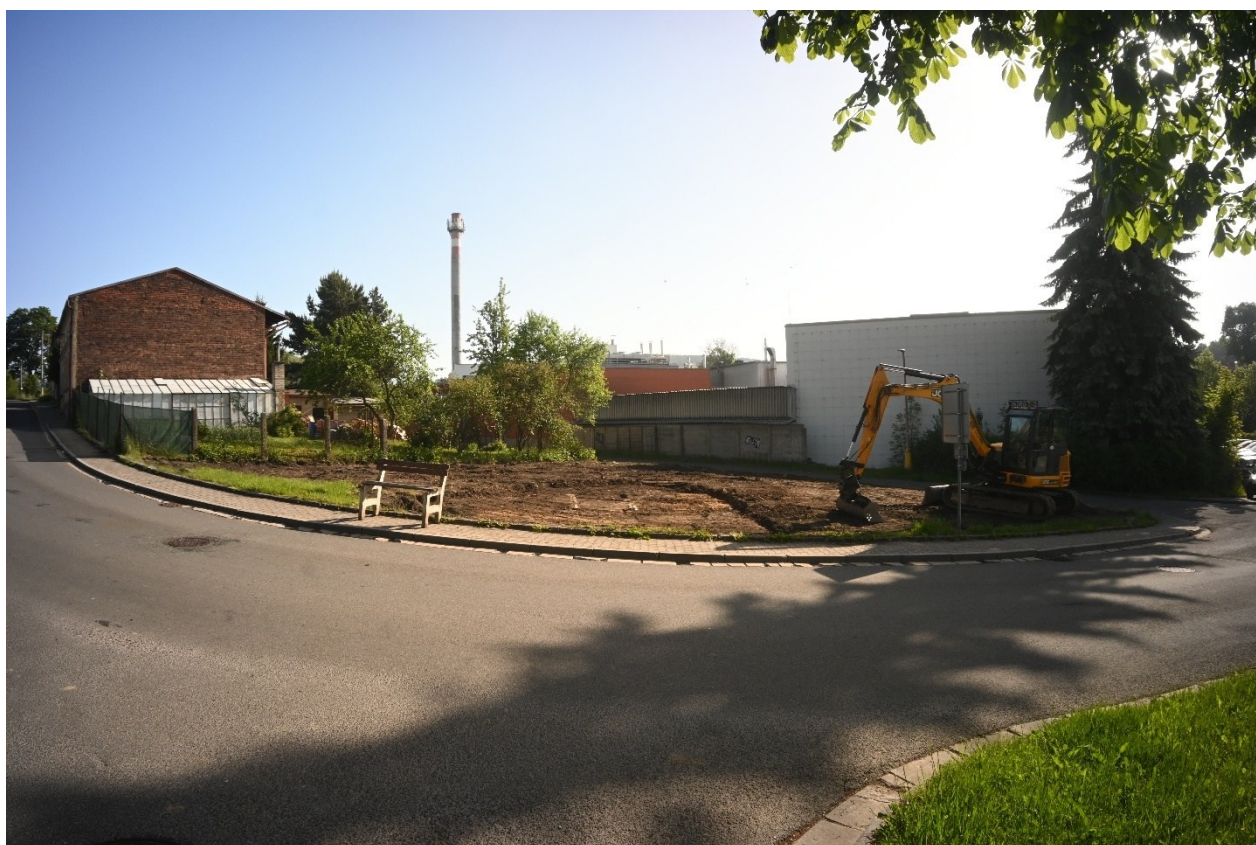
Obr. 1 – Realizace – zemní práce – stav ze dne 27. 5. 2026 ráno
