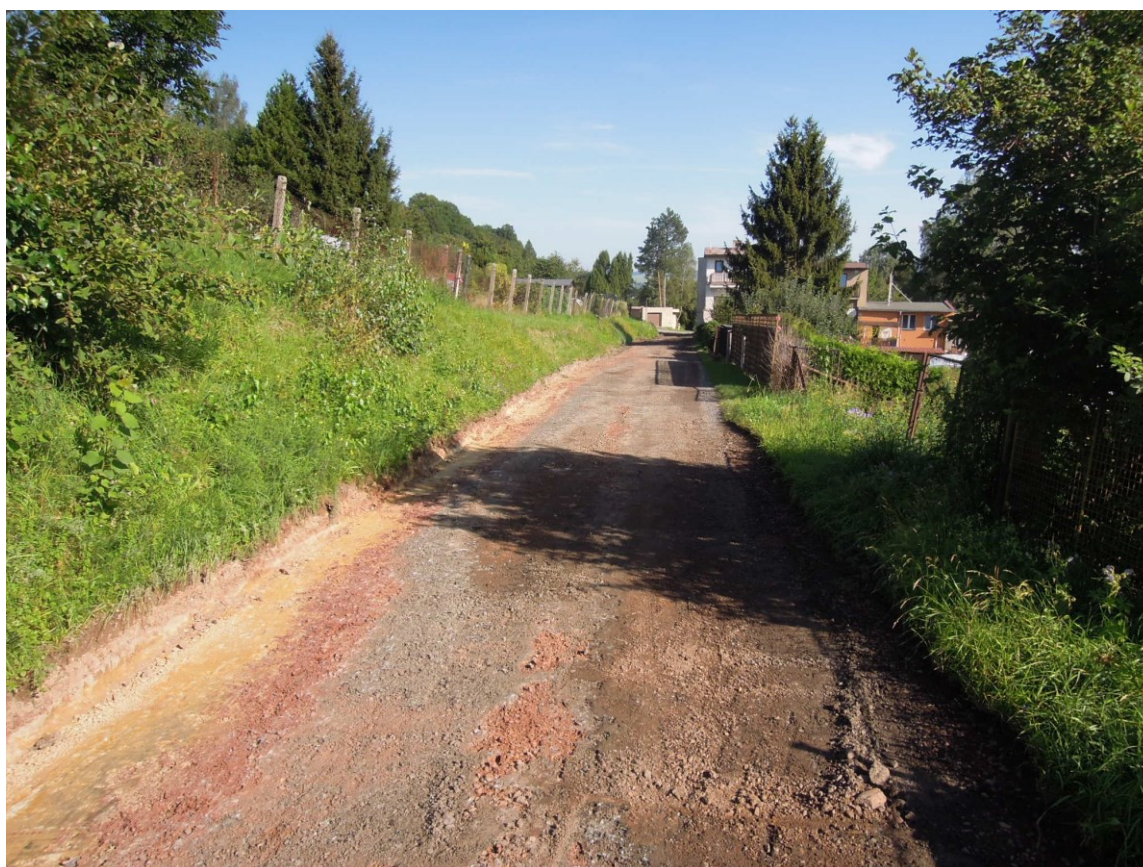
Obr. 5 – úprava podkladových vrstev před samotnou pokládkou asfaltu
