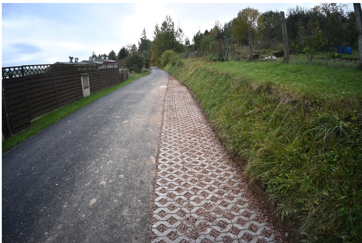
Obr. 6 – dokončená rekonstrukce komunikace včetně odstavné plochy
