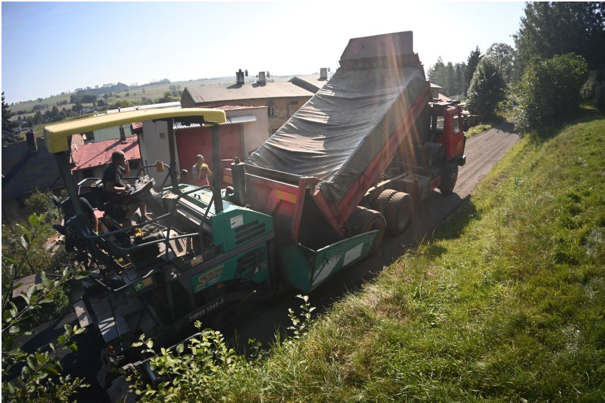
Obr. 2 – asfaltování
