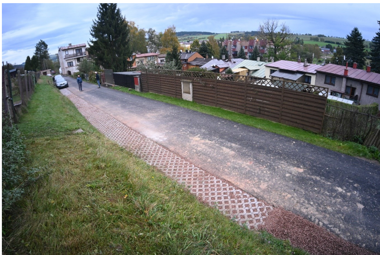
Obr. 7 - dokončená rekonstrukce komunikace včetně odstavné plochy
