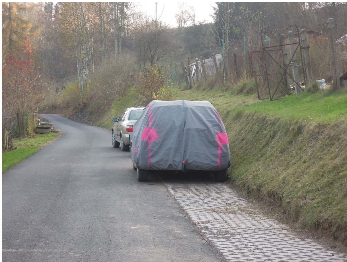
Obr. 8 – dokončená rekonstrukce komunikace včetně odstavné plochy
