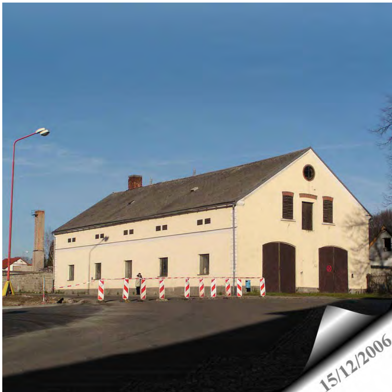
Objekt bývalé škvárovny na Komenského náměstí.
