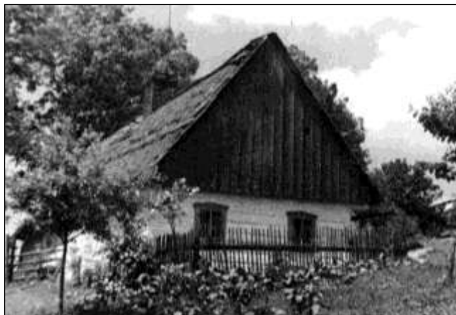
čp. 108 (výměnek k č.p. 38) - vybořeno
