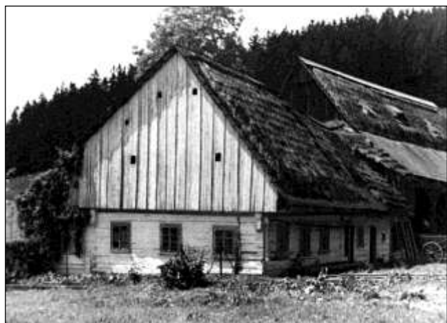
čp. 104 (výměnek k č.p. 26) - vybořeno
