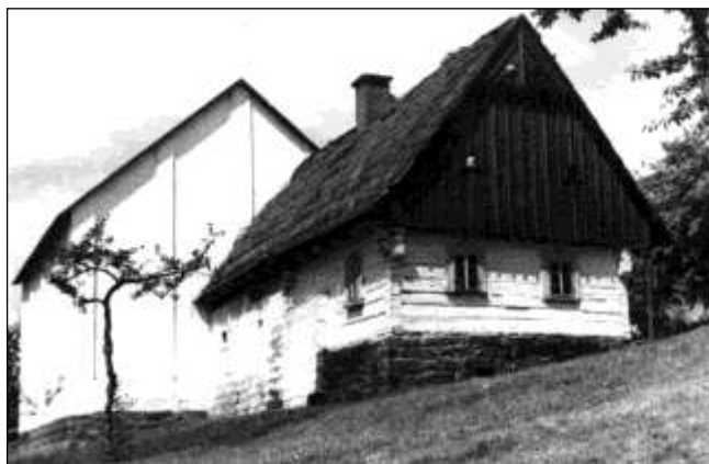
čp. 109 (výměnek k č.p. 39) - vybořeno
