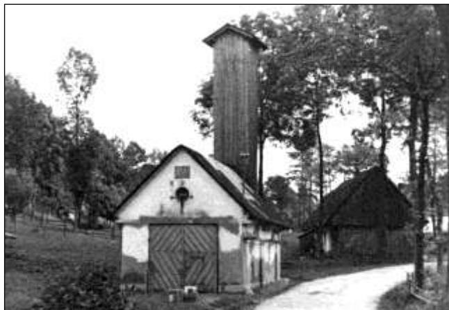
Hasičská zbrojnice - vybořeno
