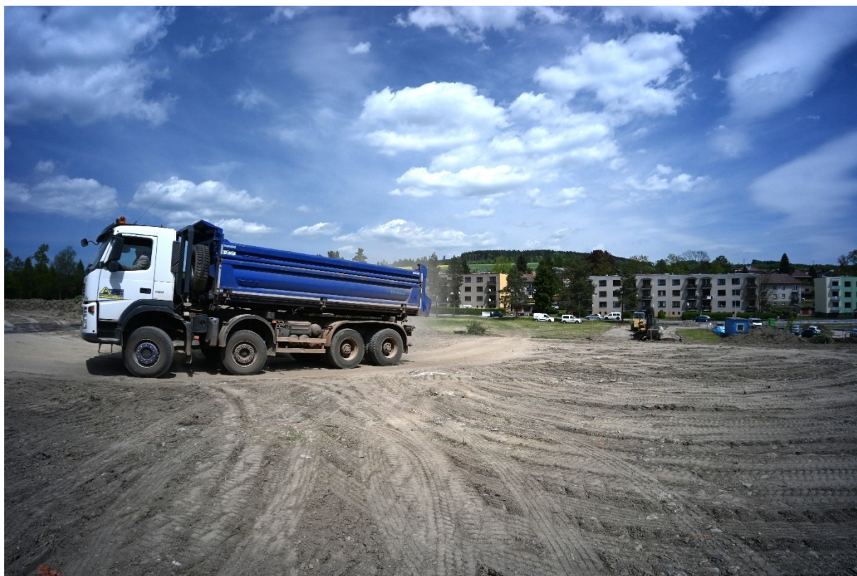
Obr. 3a, 3b – průběh stavby
