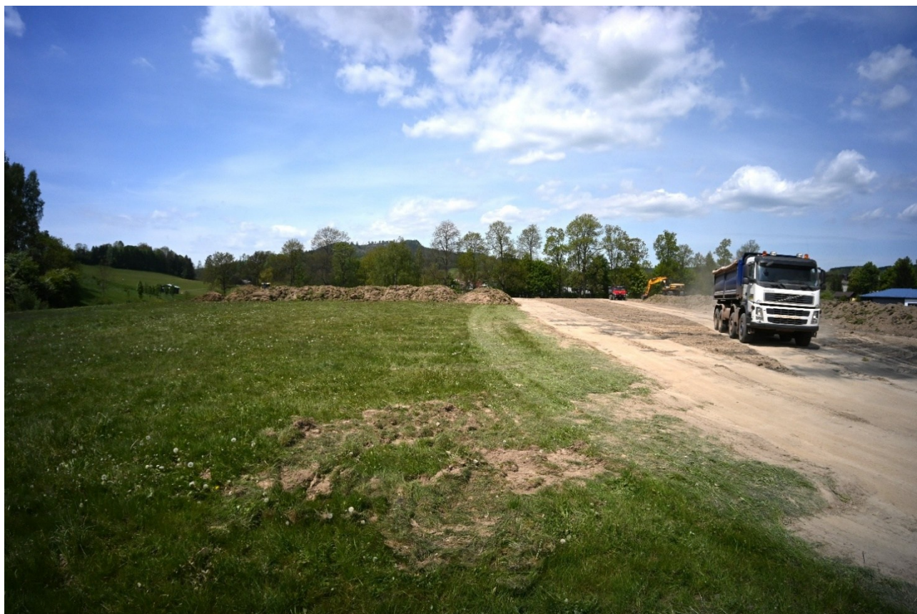
Obr. 4a, 4b – průběh stavby
